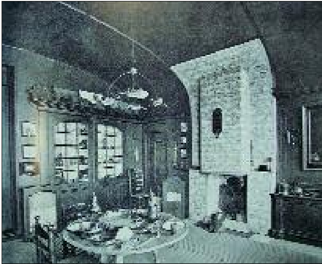
Abb. 11: Wo die Fliesen angebracht waren.
